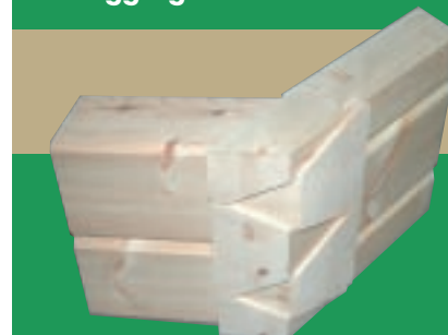
45-Grad-Schwalbenschwanz
