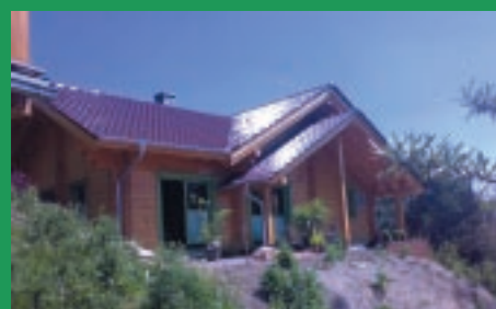
Referenzhaus 'Bad Blankenburg'
